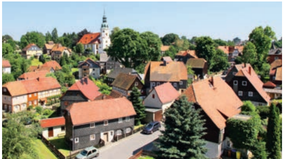
Blick aus der Vogelperspektive auf ein Ensemble von Umgebinderhäusern, sie umringen die stolze Dorfkirche.
